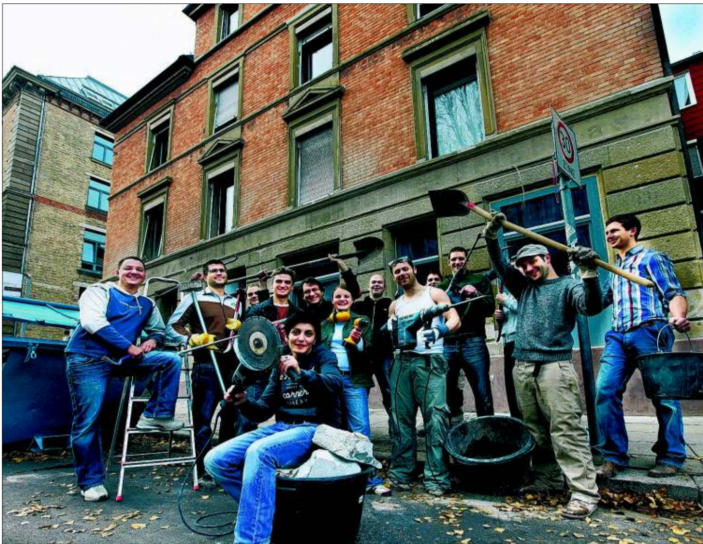
Fleißige Handwerker in der Hasenbergstraße: Die Eltern entrümpeln eine ehemalige Kneipe und machen Platz für eine Kinderkrippe
